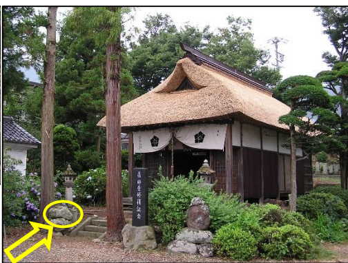
薬師堂と目洗い石 茅葺屋根完成直後(平成11年)の写真
